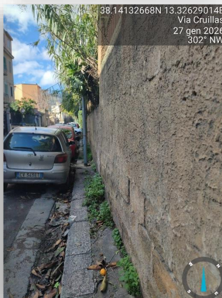
LARGHEZZA INADEGUATA/ OSTACOLI
