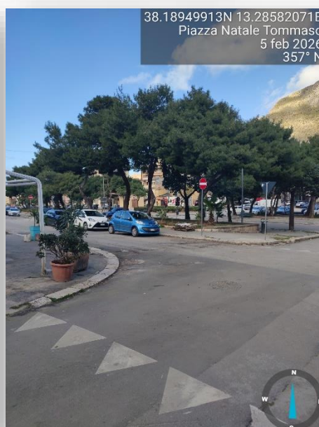
ASSENZA DI RAMPA
