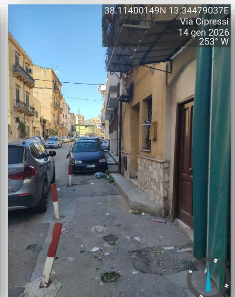
DISLIVELLO/ LARGHEZZA NON ADEGUATA
