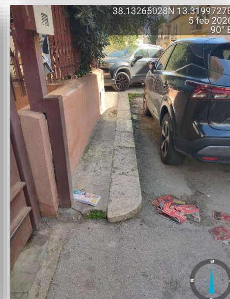
DISLIVELLO/ LARGHEZZA NON ADEGUATA
