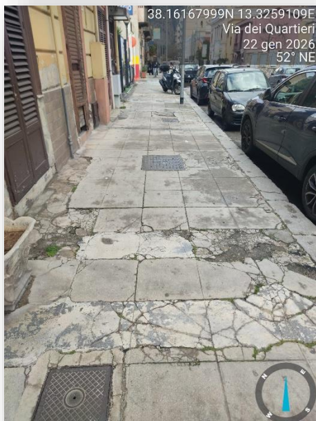
PAVIMENTAZIONE SCONNESSA/ OSTACOLI
