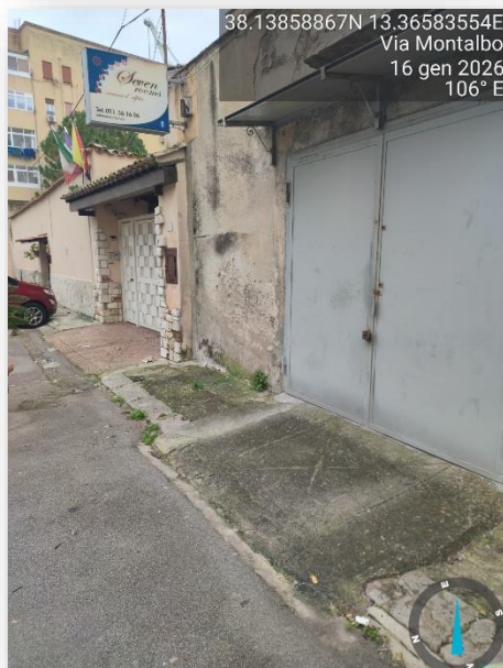
PAVIMENTAZIONE SCONNESSA/ DISLIVELLO
