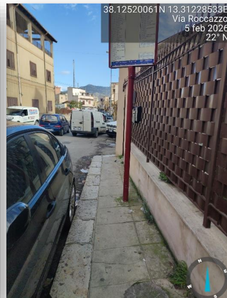
LARGHEZZA NON ADEGUATA/ OSTACOLO
