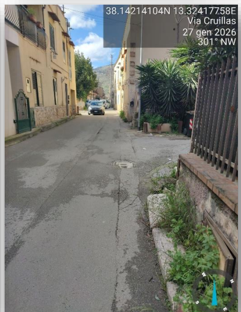
LARGHEZZA INADEGUATA/ ASSENZA MARCIAPIEDE
