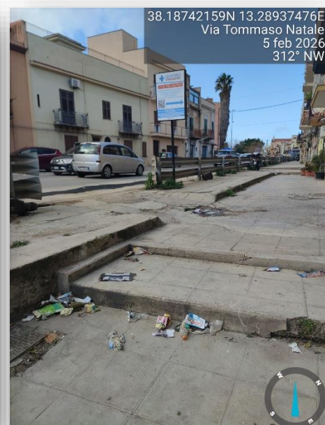
GRADINI/ ASSENZA DI RAMPA
