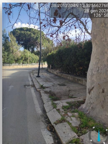
PAVIMENTAZIONE SCONNESSA/ OSTACOLI
