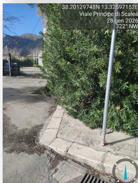
LARGHEZZA INADEGUATA/ OSTACOLI
