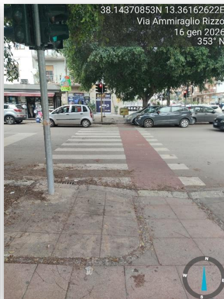
ATTRAVERSAMENTO NON ADEGUATO
