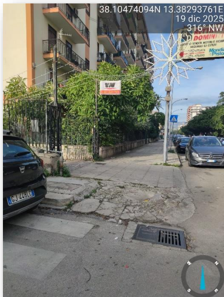
ATTRAVERSAMENTO NON ADEGUATO
