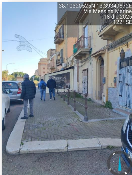
SUPERFICIE DISCONTINUA/ DISLIVELLO
