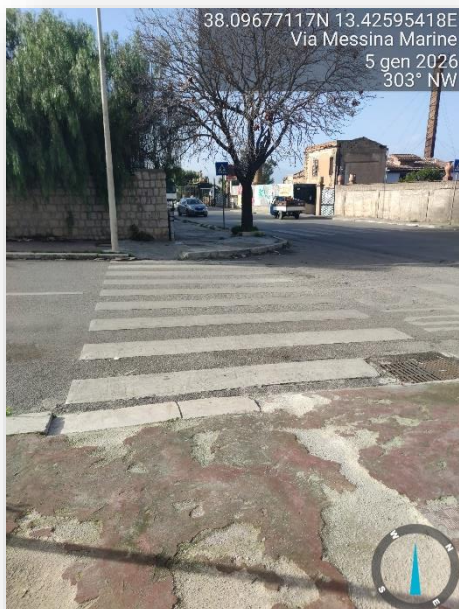
ATTRAVERSAMENTO NON ADEGUATO
