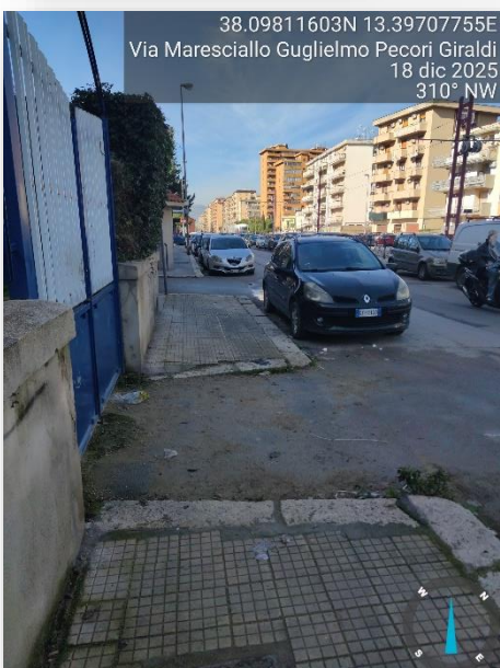
ATTRAVERSAMENTO NON ADEGUATO
