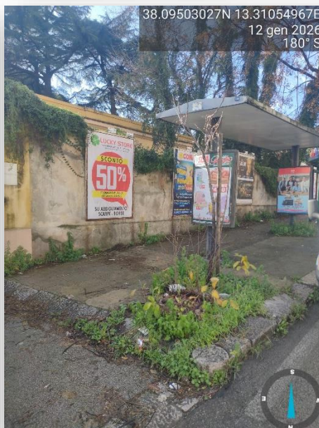
PAVIMENTAZIONE SCONNESSA
