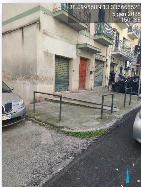
OSTACOLI SU PAVIMENTAZIONE SCONNESSA
