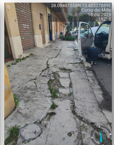
PAVIMENTAZIONE SCONNESSA
