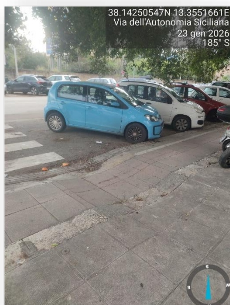
PAVIMENTAZIONE NON IDONEA E DISLIVELLO
