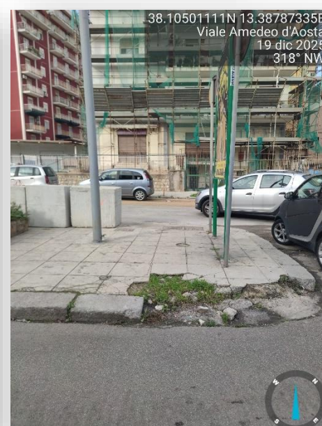
ATTRAVERSAMENTO NON ADEGUATO
