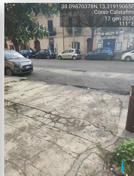
PAVIMENTAZIONE SCONNESSA
