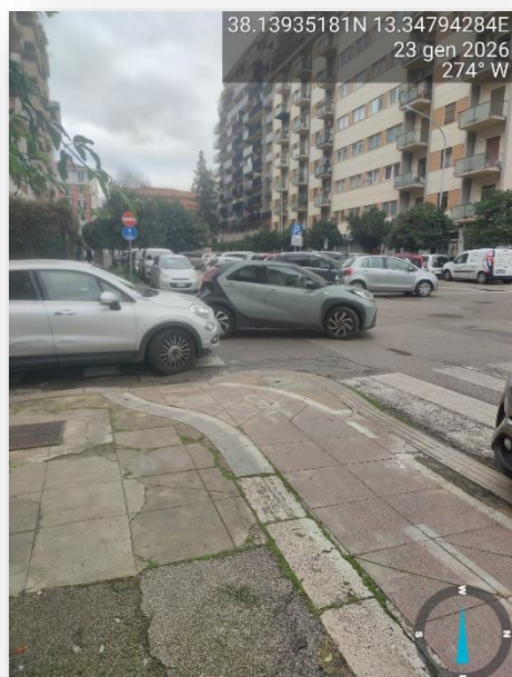
ATTRAVERSAMENTO NON ADEGUATO
