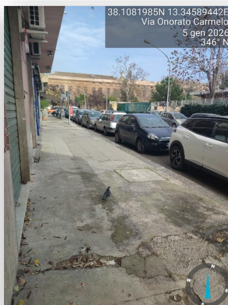
PAVIMENTAZIONE SCONNESSA
