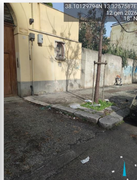
ATTRAVERSAMENTO NON ADEGUATO
