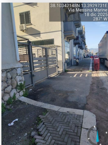
ATTRAVERSAMENTO NON IDONEO
