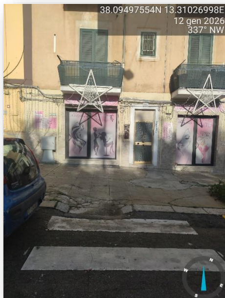
ATTRAVERSAMENTO NON ADEGUATO
