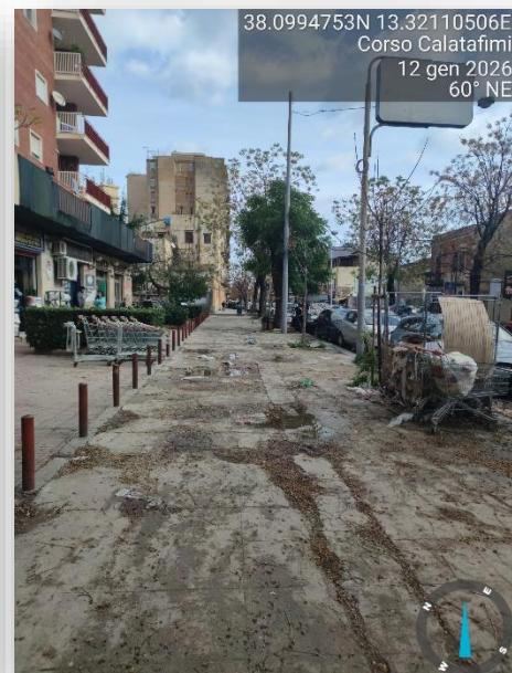
PAVIMENTAZIONE SCONNESSA
