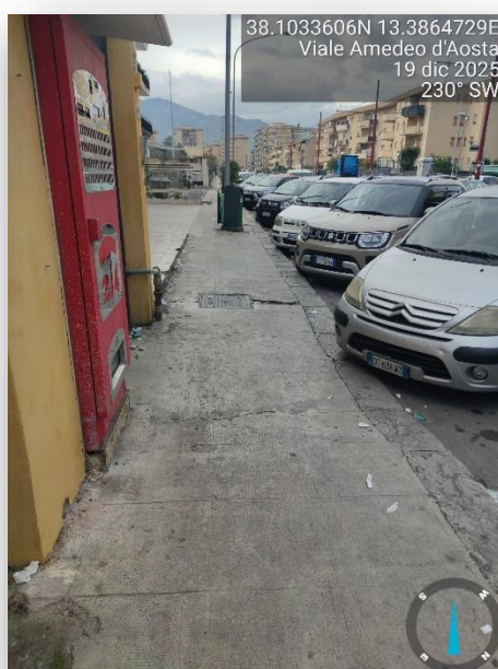
PAVIMENTAZIONE SCONNESSA E OSTACOLI
