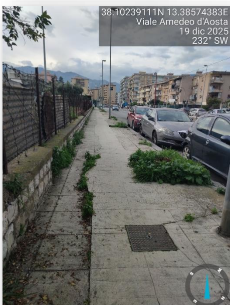
PAVIMENTAZIONE SCONNESSA E OSTACOLI
