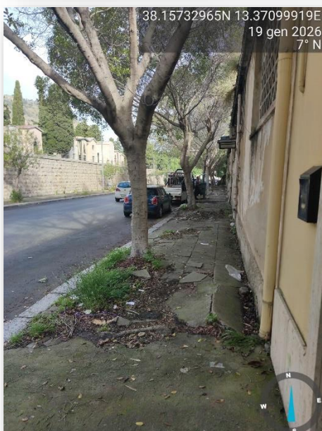
PAVIMENTAZIONE NON IDONEA E OSTACOLI
