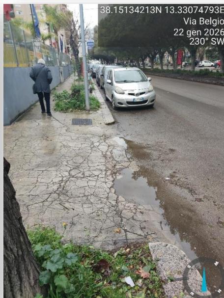
PAVIMENTAZIONE SCONNESSA
