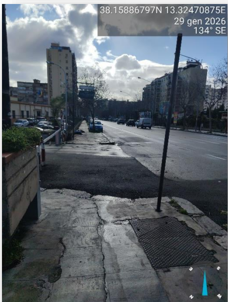
PAVIMENTAZIONE SCONNESSA
