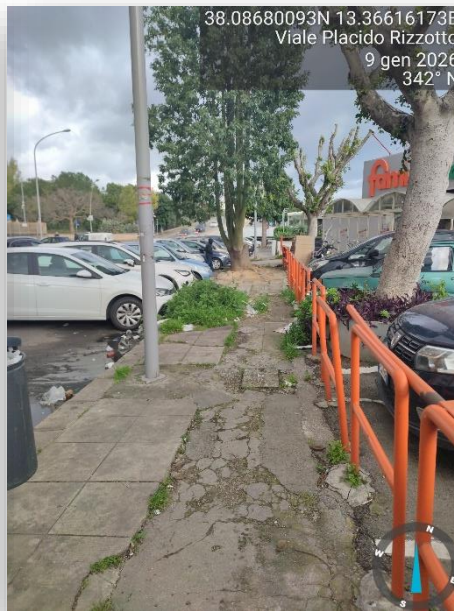
PAVIMENTAZIONE SCONNESSA
