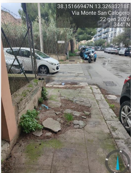
PAVIMENTAZIONE SCONNESSA
