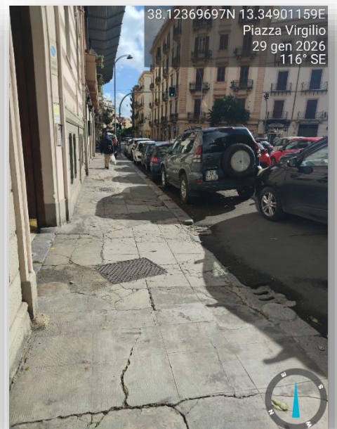
PAVIMENTAZIONE SCONNESSA
