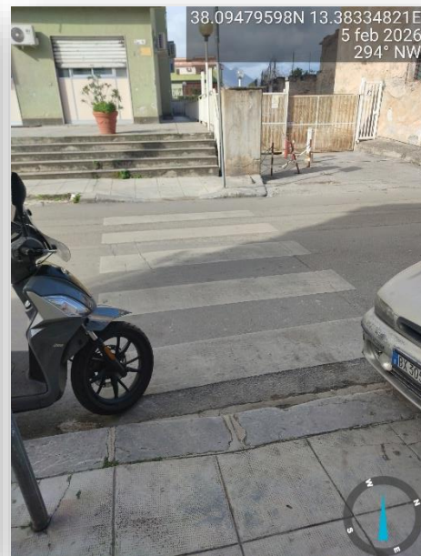
ATTRAVERSAMENTO NON ADEGUATO
