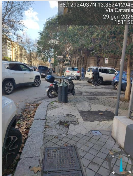
PAVIMENTAZIONE SCONNESSA/OSTACOLI
