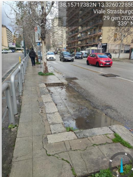
PAVIMENTAZIONE SCONNESSA
