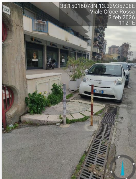
DISLIVELLO/PENDENZA ECCESSIVA
