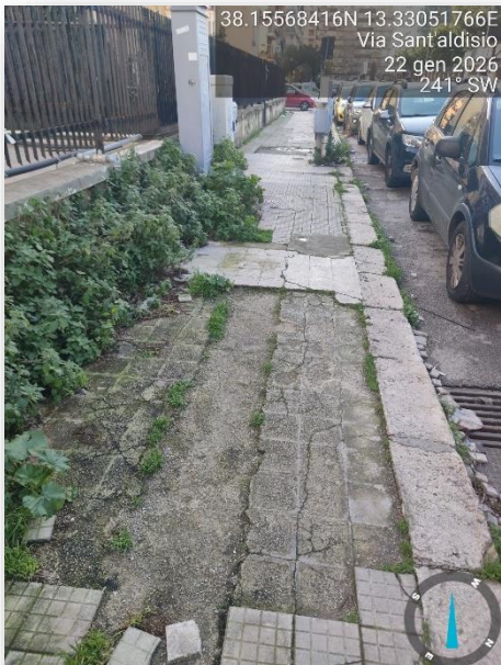
PAVIMENTAZIONE SCONNESSA
