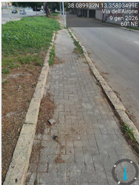
PAVIMENTAZIONE SCONNESSA/OSTACOLI
