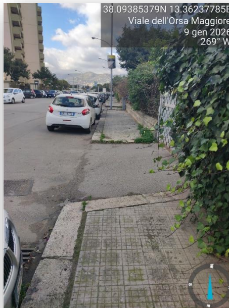
PAVIMENTAZIONE SCONNESSA
