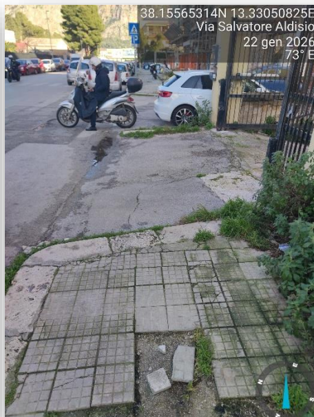
ATTRAVERSAMENTO NON IDONEO /OSTACOLI
