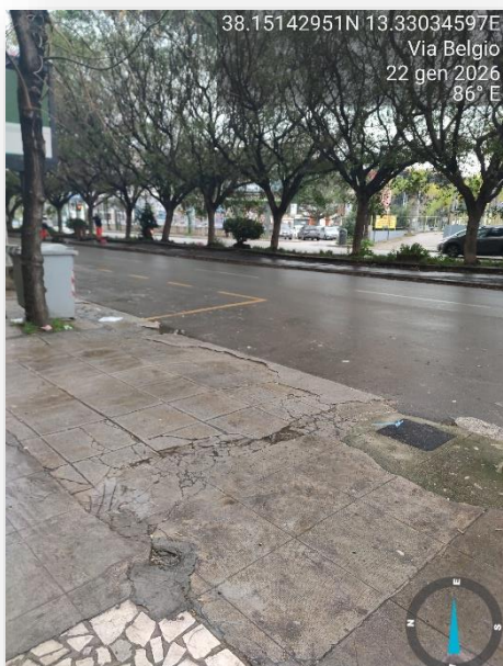
PAVIMENTAZIONE SCONNESSA
