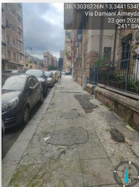
PAVIMENTAZIONE SCONNESSA
