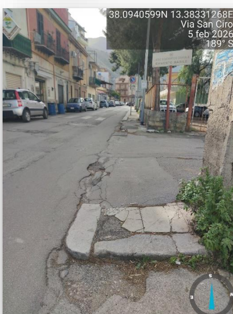
PAVIMENTAZIONE SCONNESSA
