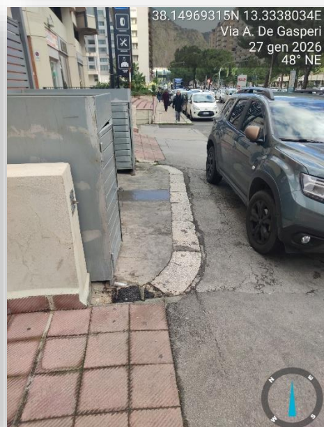
PAVIMENTAZIONE SCONNESSA
