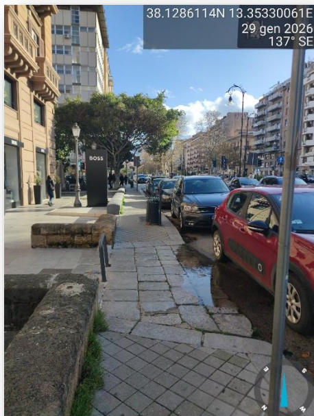
PAVIMENTAZIONE SCONNESSA
