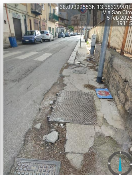
PAVIMENTAZIONE SCONNESSA
