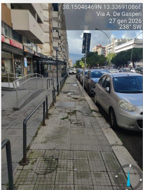
PAVIMENTAZIONE SCONNESSA
