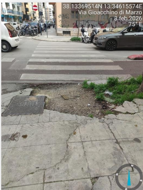
PAVIMENTAZIONE SCONNESSA
