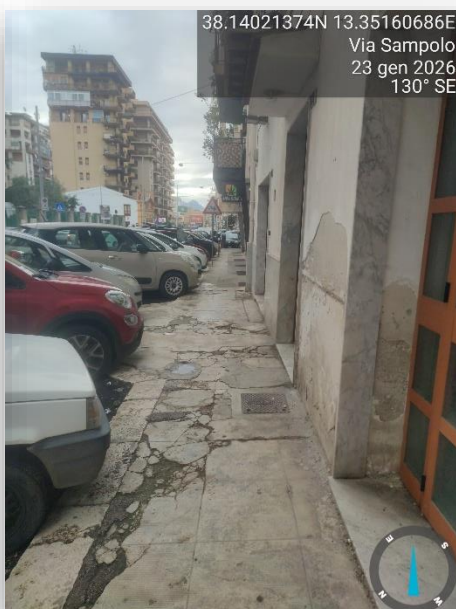
PAVIMENTAZIONE SCONNESSA
