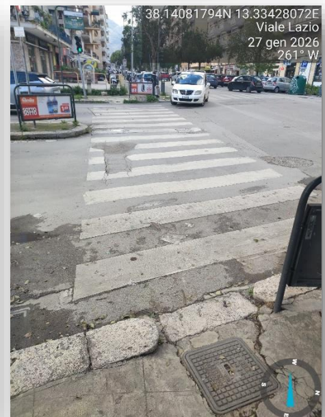
ATTRAVERSAMENTO NON IDONEO
