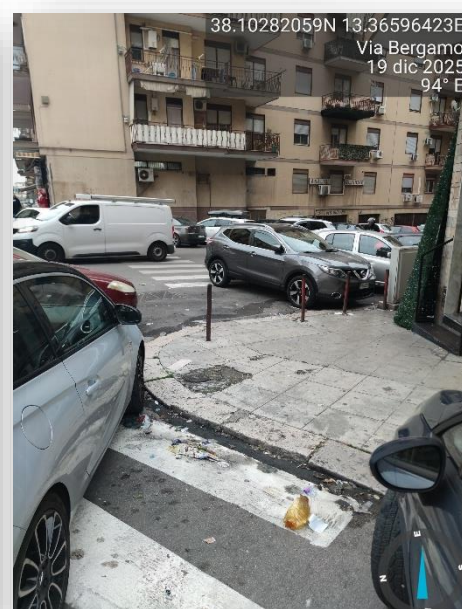
ATTRAVERSAMENTO NON IDONEO
