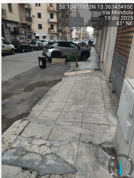
PAVIMENTAZIONE SCONNESSA
