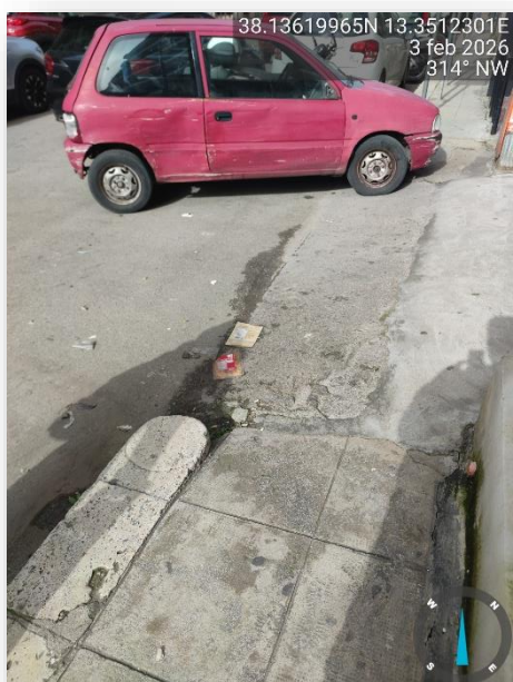
PAVIMENTAZIONE SCONNESSA
