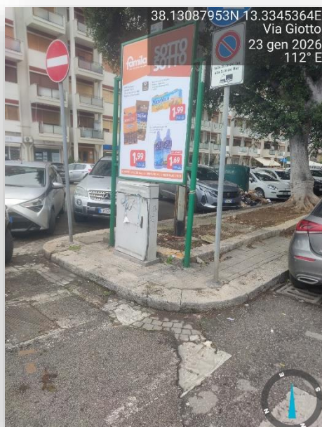
ATTRAVERSAMENTO NON IDONEO/OSTACOLI
