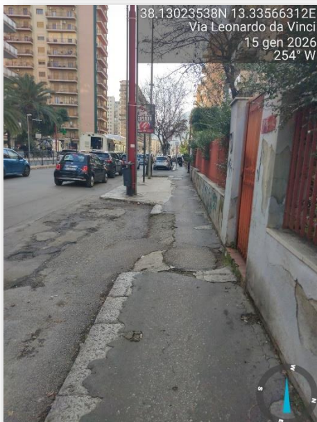
PAVIMENTAZIONE SCONNESSA
