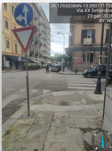
ATTRAVERSAMENTO NON IDONEO
