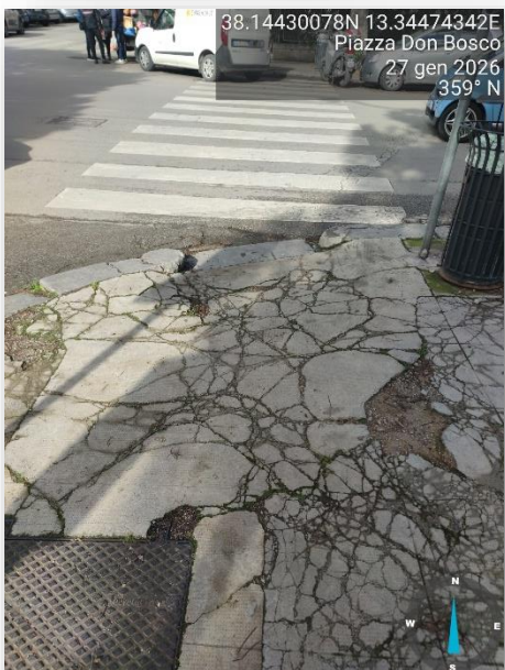
PAVIMENTAZIONE SCONNESSA
