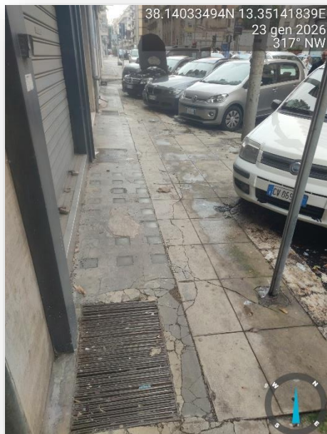
PAVIMENTAZIONE SCONNESSA E OSTACOLI
