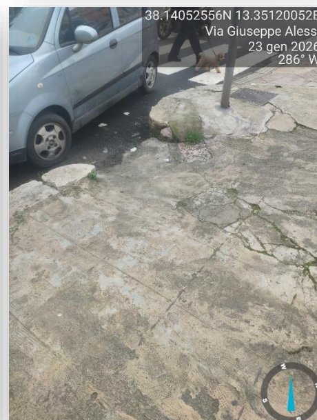
PAVIMENTAZIONE SCONNESSA
