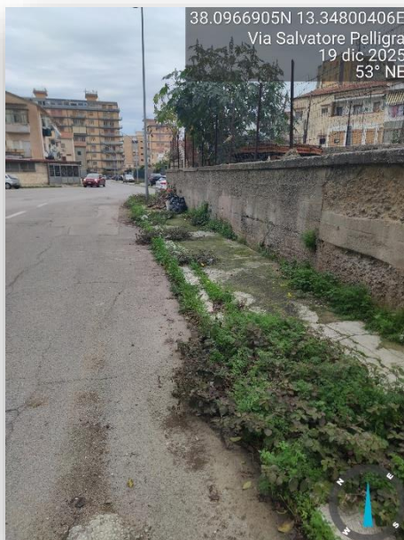
PAVIMENTAZIONE SCONNESSA
