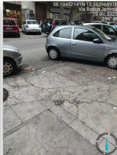
PAVIMENTAZIONE SCONNESSA
