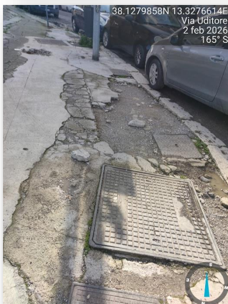
PAVIMENTAZIONE SCONNESSA
