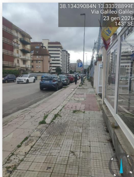
PAVIMENTAZIONE SCONNESSA
