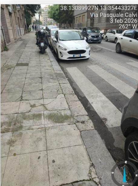
ATTRAVERSAMENTO NON IDONEO
