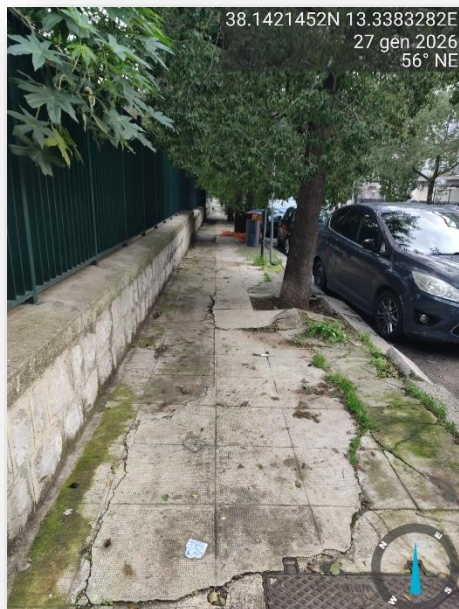
PAVIMENTAZIONE SCONNESSA
