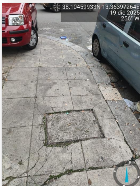
PAVIMENTAZIONE SCONNESSA
