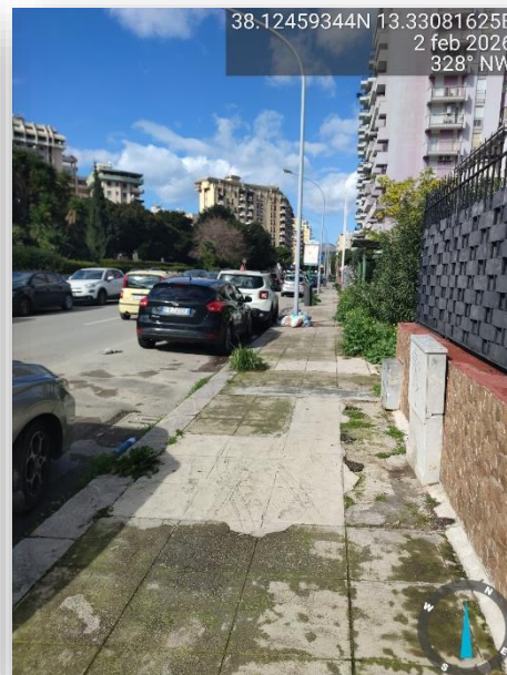
PAVIMENTAZIONE SCONNESSA
