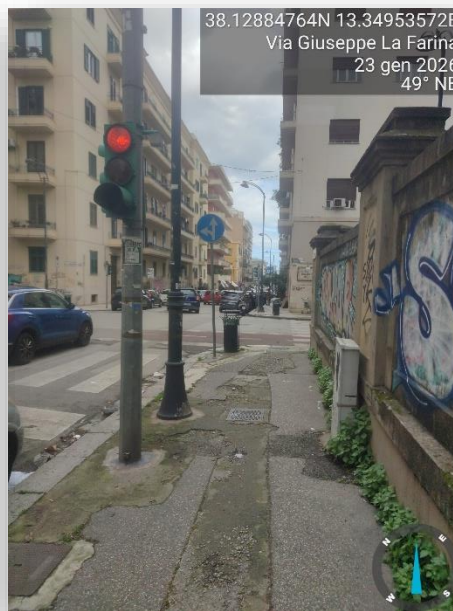
PAVIMENTAZIONE SCONNESSA
