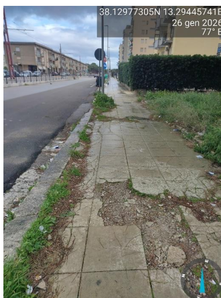
PAVIMENTAZIONE SCONNESSA
