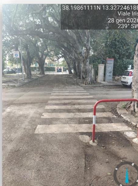
ATTRAVERSAMENTO NON ADEGUATO
