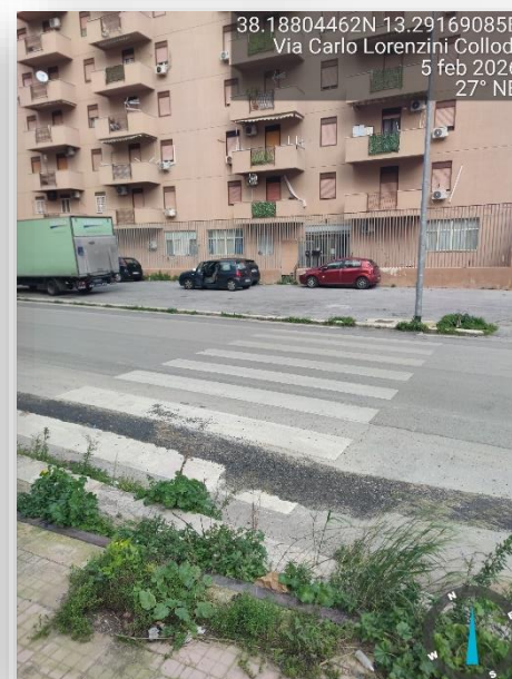
ATTRAVERSAMENTO NON ADEGUATO
