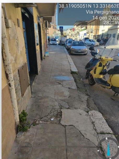
PAVIMENTAZIONE SCONNESSA
