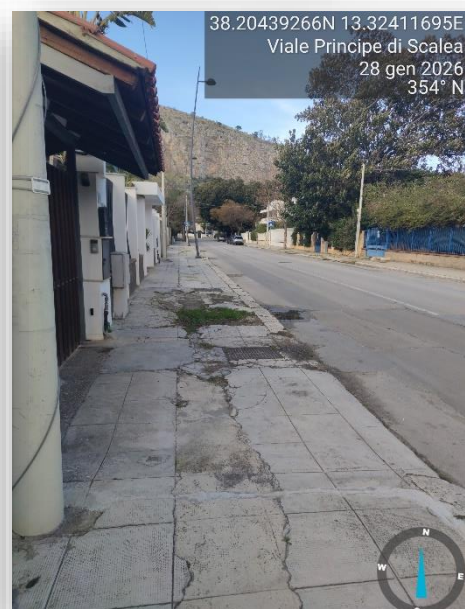
PAVIMENTAZIONE SCONNESSA
