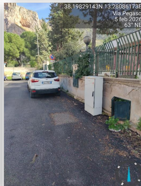
ASSENZA PERCORSO PEDONALE
