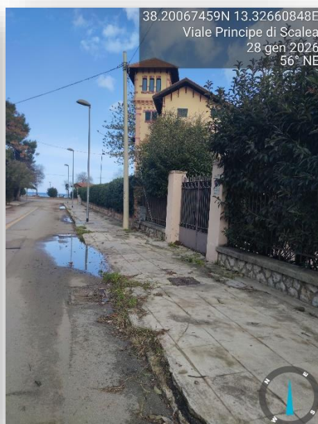
PAVIMENTAZIONE SCONNESSA
