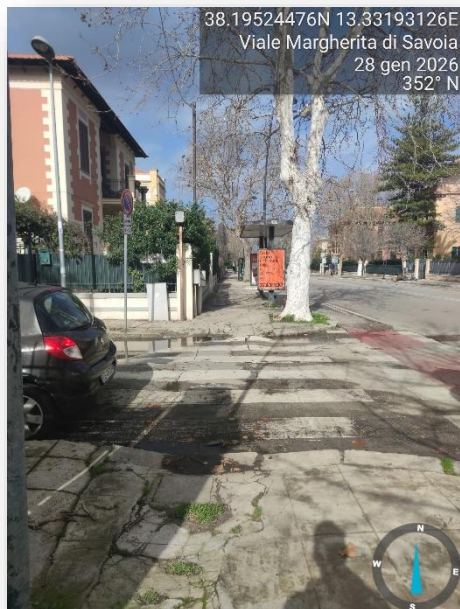
ATTRAVERSAMENTO NON ADEGUATO
