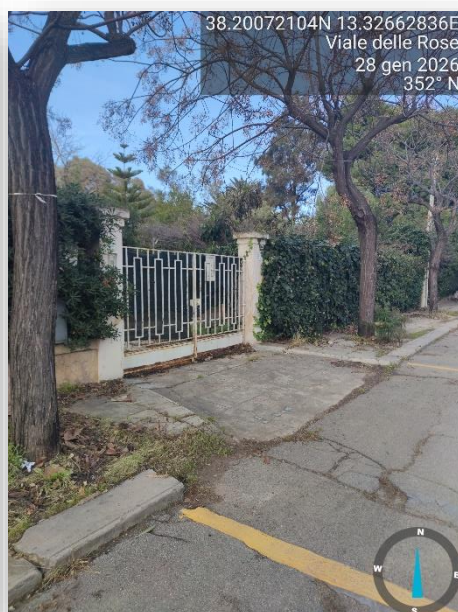
ATTRAVERSAMENTO NON ADEGUATO
