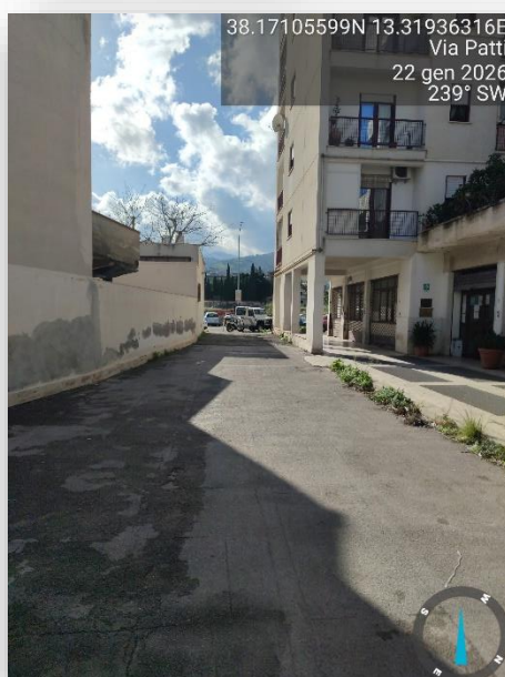
PAVIMENTAZIONE SCONNESSA
