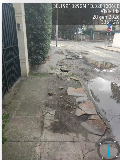
PAVIMENTAZIONE SCONNESSO
