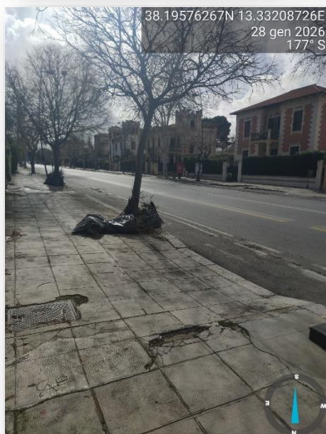
PAVIMENTAZIONE SCONNESSA
