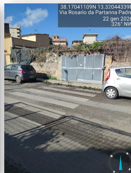
ATTRAVERSAMENTO NON IDONEO
