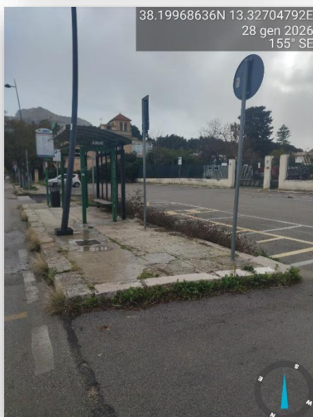
ATTRAVERSAMENTO NON ADEGUATO
