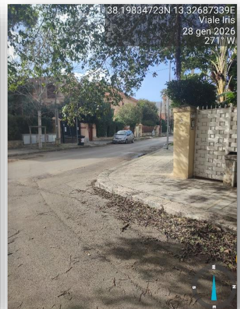
ATTRAVERSAMENTO NON ADEGUATO
