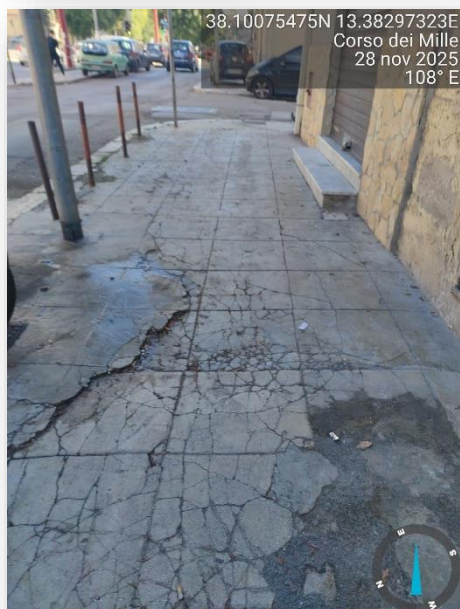
PAVIMENTAZIONE SCONNESSA
