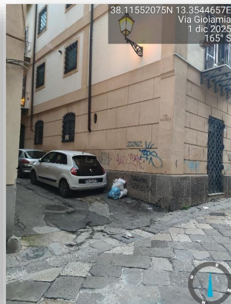
PAVIMENTAZIONE SCONNESSA/MANCANZA PERCORSO PEDONALE
