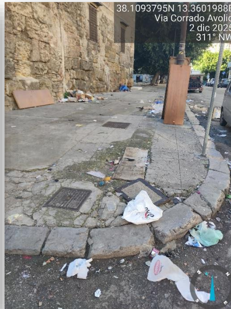
DISLIVELLO/PAVIMENTAZIONE SCONNESSA
