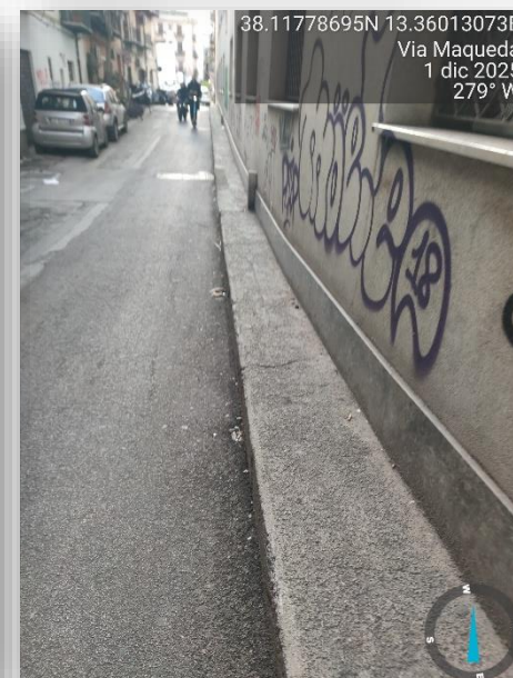
LARGHEZZA PERCORSO PEDONALE NON ADEGUATA
