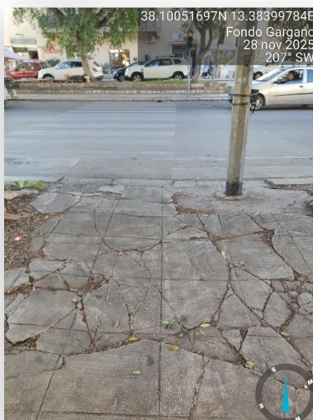
PAVIMENTAZIONE SCONNESSA
