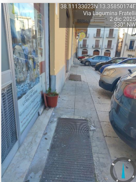
PAVIMENTAZIONE SCONNESSA
