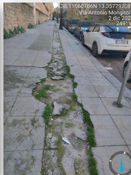
PAVIMENTAZIONE SCONNESSA
