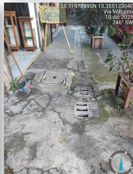
PAVIMENTAZIONE SCONNESSA
