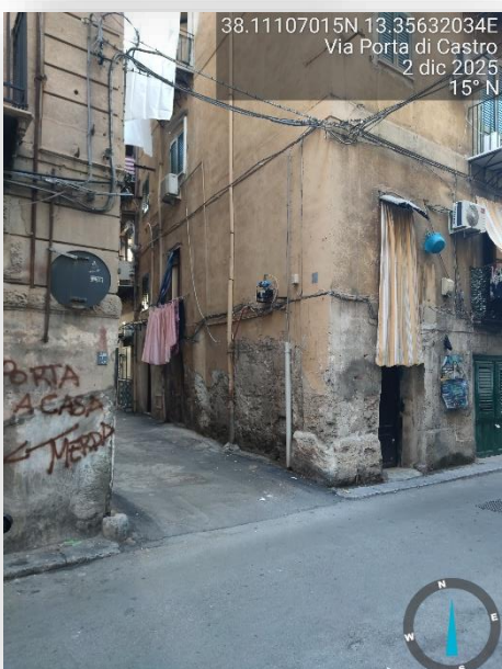
ASSENZA DI MARCIAPIEDE
