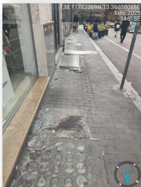
GRIGLIE/ PAVIMENTAZIONE SDRUCCIOLEVOLE
