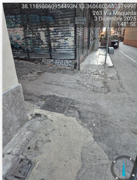
PAVIMENTAZIONE SCONNESSA
