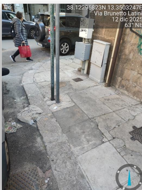
PAVIMENTAZIONE SCONNESSA/ OSTACOLI
