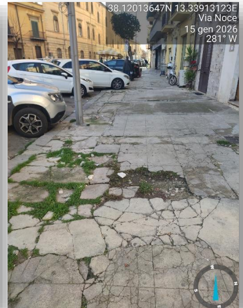
PAVIMENTAZIONE SCONNESSA
