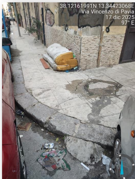
DISLIVELLO/ ASSENZA RAMPA
