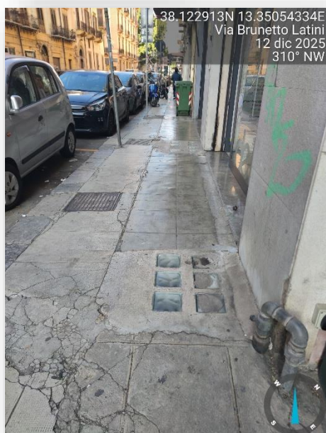
PAVIMENTAZIONE SCONNESSA/ GRIGLIE
