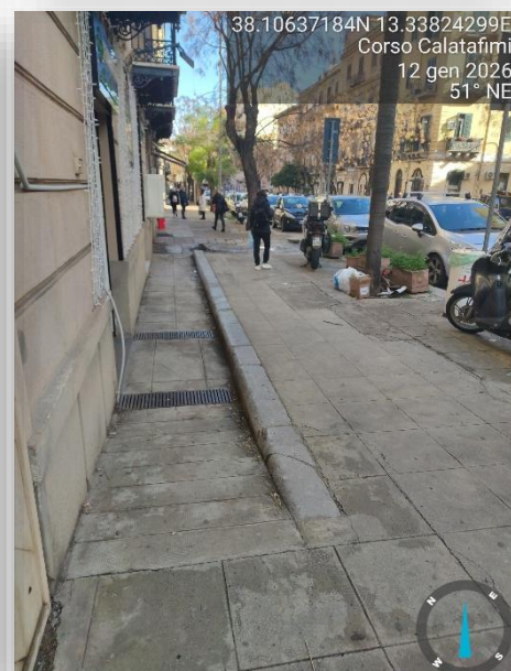
PERCORSO PEDONALE NON DELIMITATO
