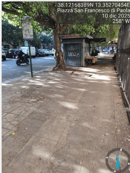
PAVIMENTAZIONE SCONNESSA
