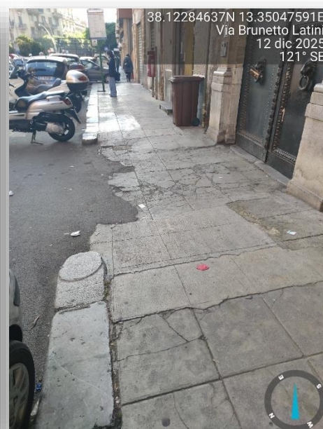
PAVIMENTAZIONE SCONNESSA
