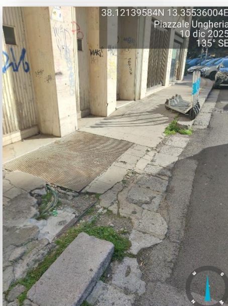
PAVIMENTAZIONE SCONNESSA/GRIGLIE
