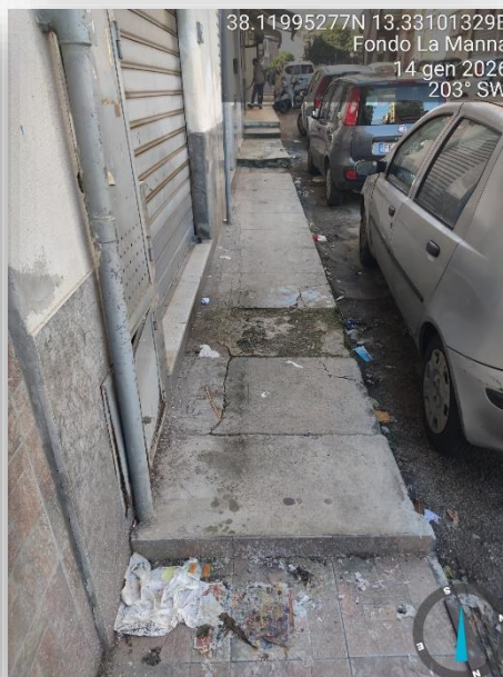
GRADINI/LARGHEZZA NON ADEGUATA
