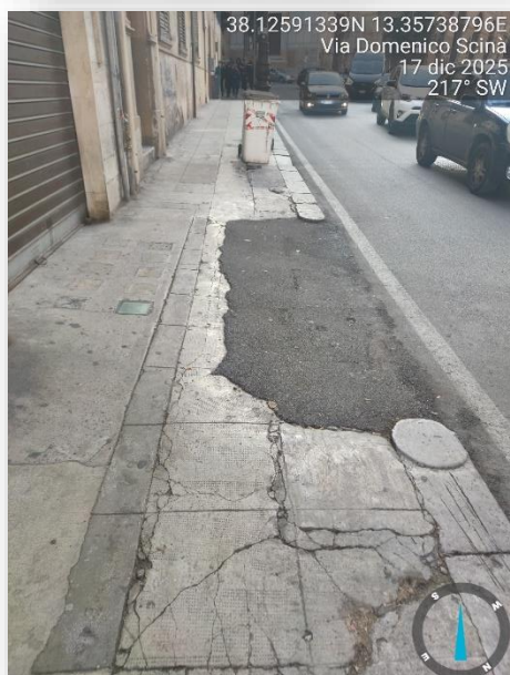
PAVIMENTAZIONE SCONNESSA
