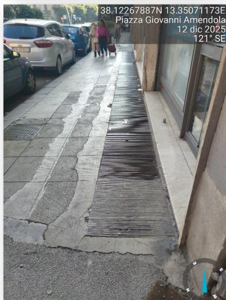
PAVIMENTAZIONE SCONNESSA/ GRIGLIE
