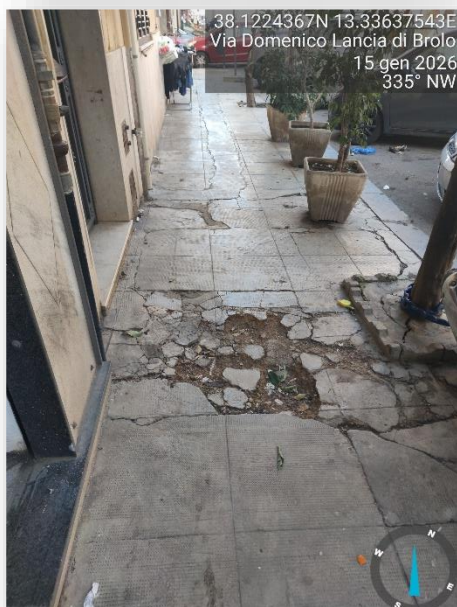
PAVIMENTAZIONE SCONNESSA
