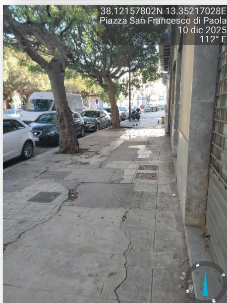
PAVIMENTAZIONE SCONNESSA/GRIGLIE
