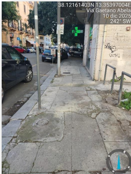
PAVIMENTAZIONE SCONNESSA/OSTACOLI
