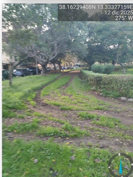
PAVIMENTAZIONE SCONNESSA/PRESENZA DI VEGETAZIONE
