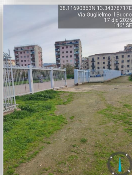
CORDOLO 'INGRESSO/SUPERFICIE IRREGOLARE
