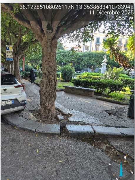
PAVIMENTAZIONE SCONNESSA/ PANCHINA NON INCLUSIVA
