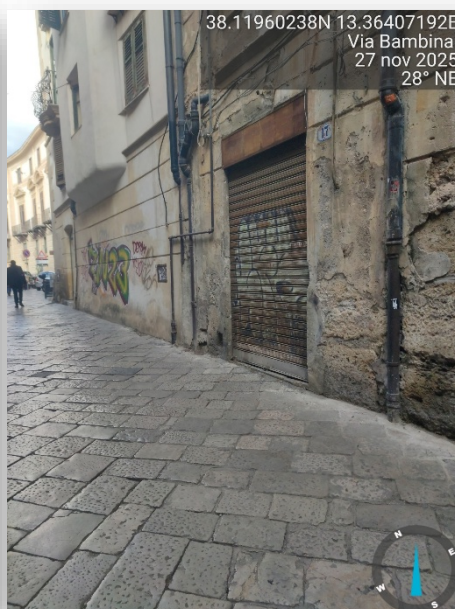
PERCORSO PEDONALE ASSENTE
