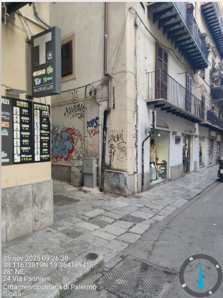
ATTRAVERSAMENTO NON ADEGUATO
