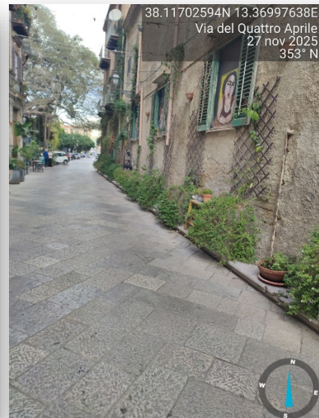
PERCORSO PEDONALE ASSENTE
