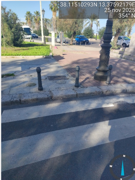
ATTRAVERSAMENTO NON ADEGUATO
