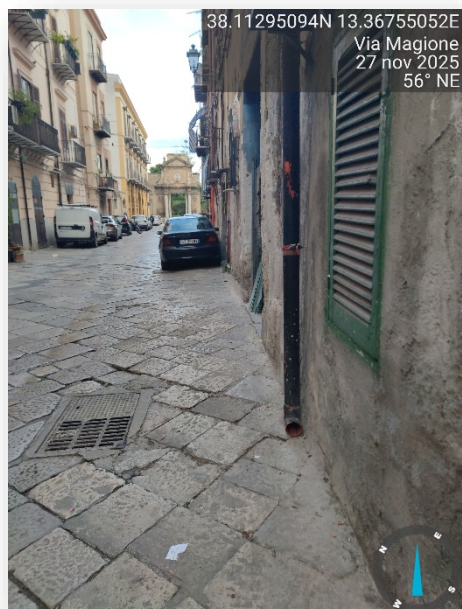
ASSENZA PERCORSO PEDONALE
