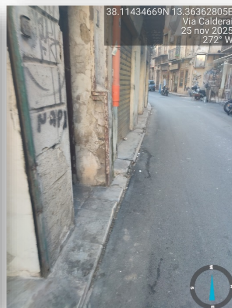
ASSENZA PERCORSO PEDONALE
