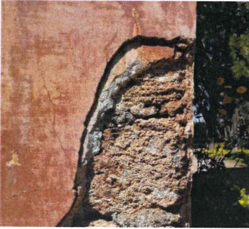
14. Dettaglio della stratificazione dell'intonaco nella base.
