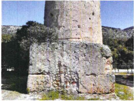
20. Dettaglio del basamento dove si può osservare l'opera di rincoccatura per il contenimento dei catusi.
